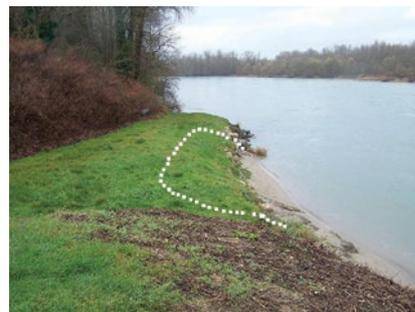
en place de plusieurs dizaines de tonnes de roches, et une couche de finition de terre végétale nous avons laissé l'ensemble se tasser, et au printemps 2014, nous avons procédé à l'engazonnement de la surface rapportée. Sur la photo, en pointillés, la zone remise en état. Nous avons constaté après 1 an que l'ensemble s'est bien stabilisé mais aussi qu'une jolie couche de sable est venu se déposer au pied de l'enrochement pour le bonheur des pêcheurs.
