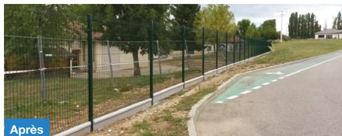
Pour des raisons de sécurité nous avons fait démolir le mur de l'école par la société BRANDO. Situé côté rue du petit veylon, celui-ci menaçait de s'effondrer. Pour le remplacer, l'option grillage rigide en panneaux soudés avec poteaux sellés a été retenue. Nous avons profité de ces travaux pour clôturer l'ensemble de l'école ainsi que la salle des fêtes.
